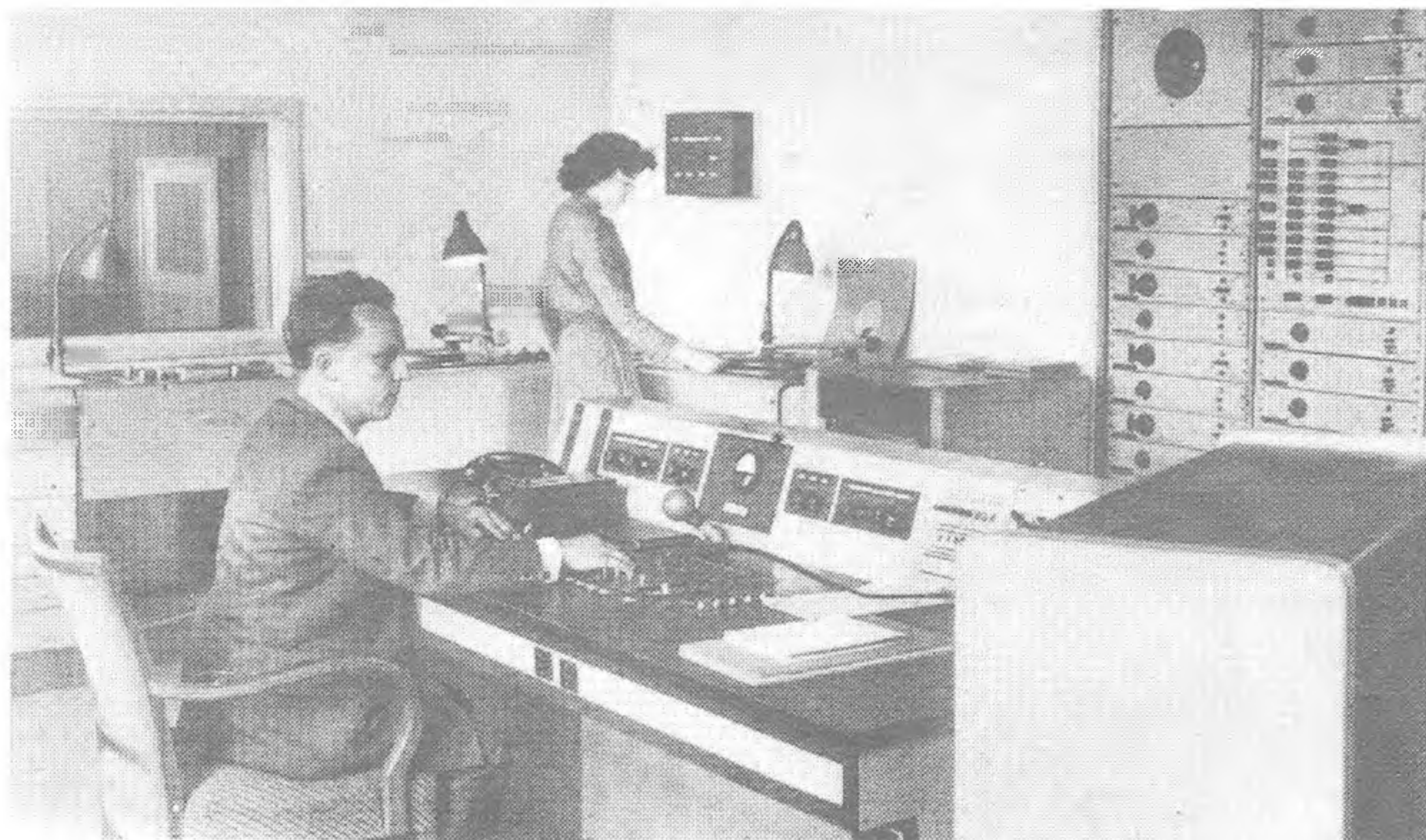
Der UKW-FM-Sender des Funkhauses, mit dem das Programm zur Sendestation übertragen wird. Rechts: Ein Kreuzschienenverteiler. Unten: Bedienungspult im Kontrollraum I, rechts im Bild das Verstärkergestell, links die Abspieleinrichtungen
