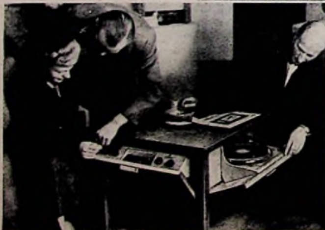
7-Kreis-7-Röhrensuper mit eingebautem Bandspielgerät, das auch mit Hilfe eines Langsamganges als Diktator benutzt werden kann
