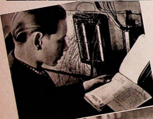
Bei der Ausbildung der Fernmeldemonteur- und Fernmeldebau-Lehrlinge wird besonderes Augenmerk auf das Löten gerichtet. Links: Auch das Schaltungsplanlesen gehört mit zur Grundausbildung. Unser Bild zeigt einen Lehrling, der an Hand eines Plans Leitungsverbindungen an einem Kabelverteiler vornimmt
