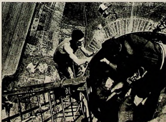
In schwindelnder Höhe zwischen Himmel und Erde wird ein Blech heraufgezogen, das oben montiert werden muß
