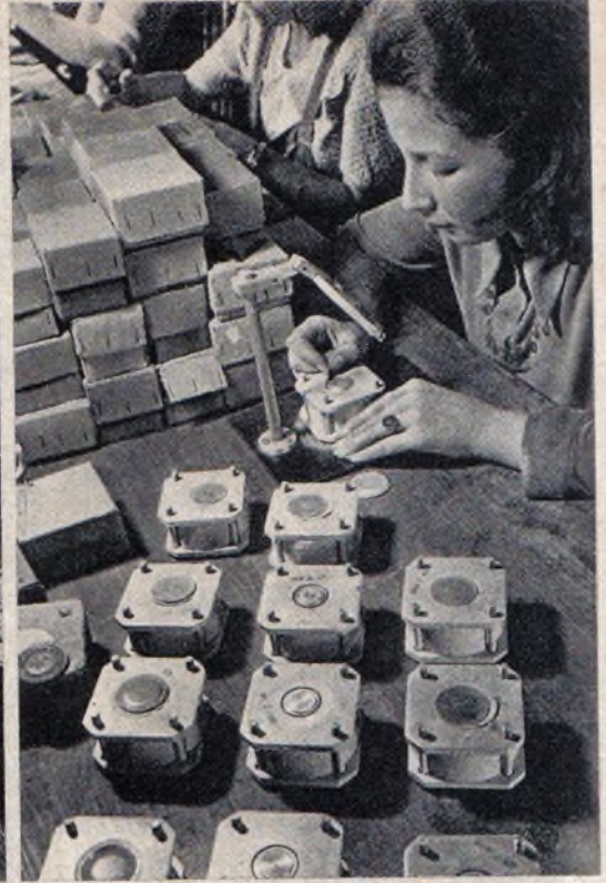
Zusammenbau der Bereichschalter (links) und Kontrolle der Lautsprechermagnete auf Leistung und Sauberkeit (rechts)
