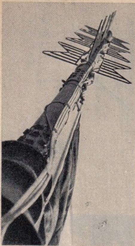
Antenne des französischen 500 Watt-Bildsenders für 819 Zeilen auf dem Eiffelturm (Versuchssender)
