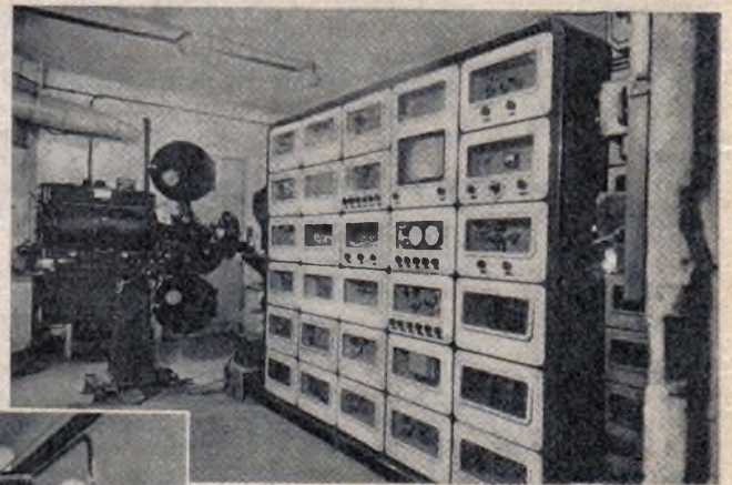
Gesamtaufnahme der Filmübertragungsanlage für 819 Zeilen mit den beiden Kinomaschinen, Kontroll- und Bildverstärker. Im Bild links: Großaufnahme der beiden Umlaufspiegel zwischen den Kinomaschinen für eine pausenlose Filmübertragung
