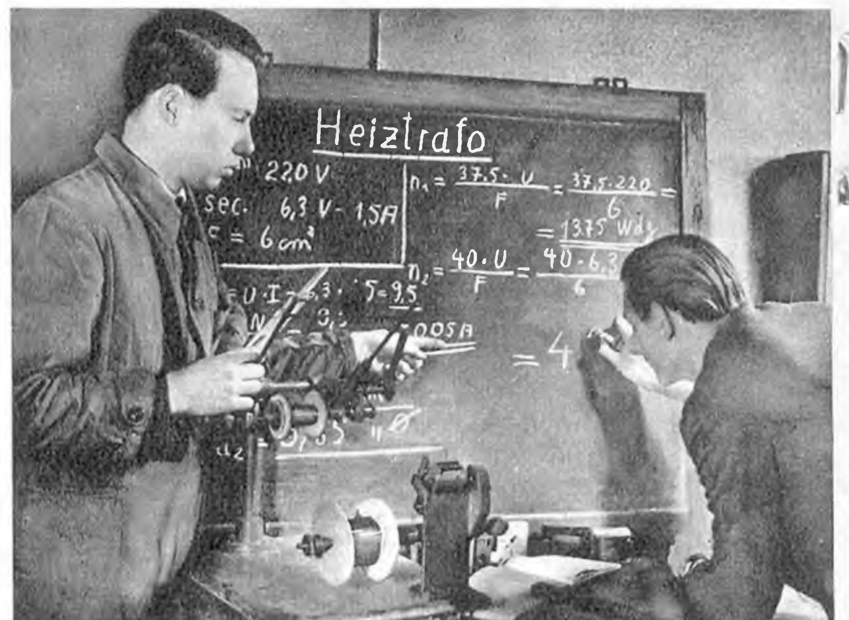
Die Berechnung für das Wickeln eines Trafos ist eine willkommene Gelegenheit, die theoretischen Kenntnisse nachzuprüfen. Links: An Hand von Industrieschaltplänen wird ein Empfänger überprüft
