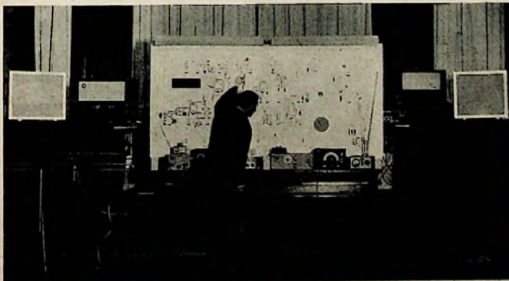
900 Angehörige des Berliner Rundfunkhandels und -handwerks hatten sich auf Einladung der S & H AG in der Technischen Universität Berlin-Charlottenburg eingefunden. An einem großen, funktionierenden Modell des Siemens-Großsupers 705 W, das auf einer Tafel von über 1,3x2,5 m aufgebaut ist, wird der Abgleich durchgeführt. An der projizierten Skala eines Mikro-Amperemeters (ganz links) und der Durchsichtprojektion des Schirmbildes eines Oszillografen (ganz rechts) können alle Vorführungen genauestens verfolgt werden
