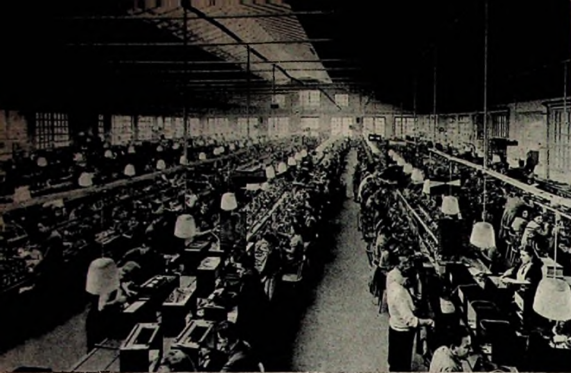
Die große Montagehalle der Grundig-Radio-Werke, Fürth. Im Oktober und November 1950 verließen je 45 000 Geräte das Werk
