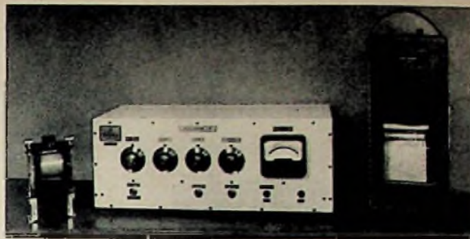
Prinzipschaltung des Programmeters, und oben das Programmeter in seiner neuesten Ausführung (von links nach rechts: Ankopplungsstraße, Verstärker, Streifenreiber)
