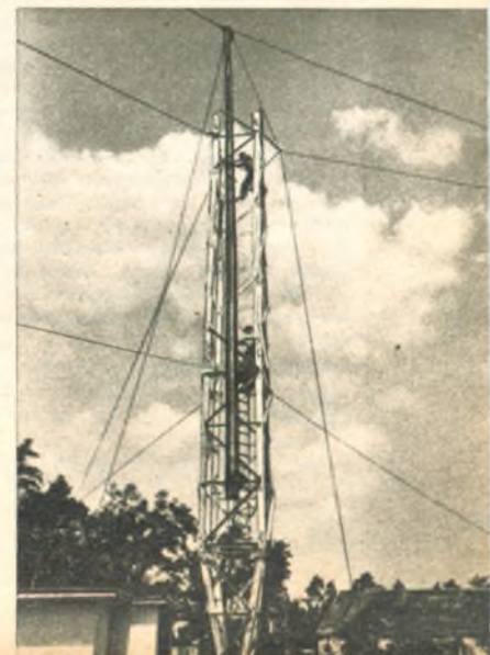
Unten: Erste Baustufe des Mastes
