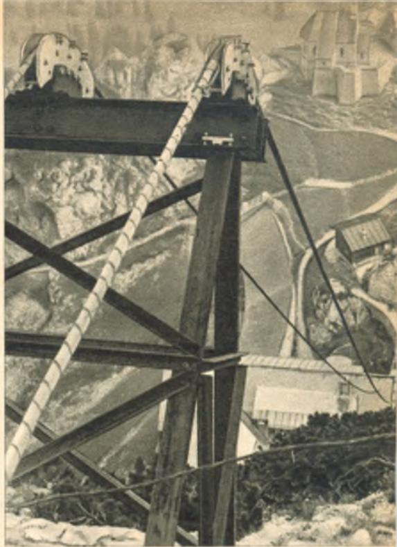
Hochfrequenz-Luftkabel u. Meßleitung zur Verbindung des im Berg-hotel Wendelstein untergebrachten Senders mit d. am Gipfel aufgestellten Richtstrahl-Antenne
