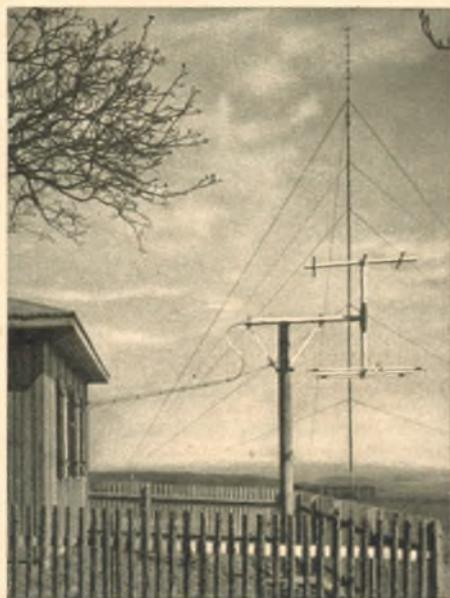
UKW-Station Coburg: Senderhäuschen mit Ballemfangs-Richtantenne, im Hintergrund die Vierfach-Quirlantenne des UKW-Senders auf einem 50 m-Rohrmast, der gleichzeitig als selbststrahlende Antenne für einen Mittelwellen-Hilfssender dient
