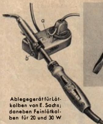
Ablegegerät für LötKolben von E. Sachs; daneben FeinlötKolben für 20 und 30 W
