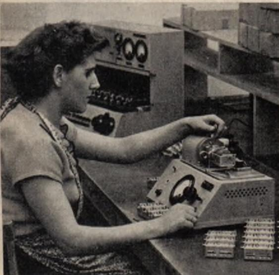
Abb. 3. Prüfgerät für Drehkondensatoren
