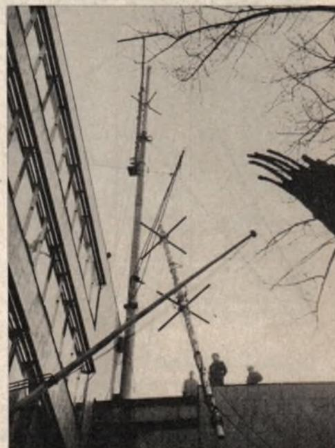
Die neue Fernsehantenne auf der Kopenhagener Technischen Hochschule wird aufgesetzt. Der Kreuzdipol für den Tonsender ist bereits oben. Es folgt der „Doppelquirl“ für den Bildsender
