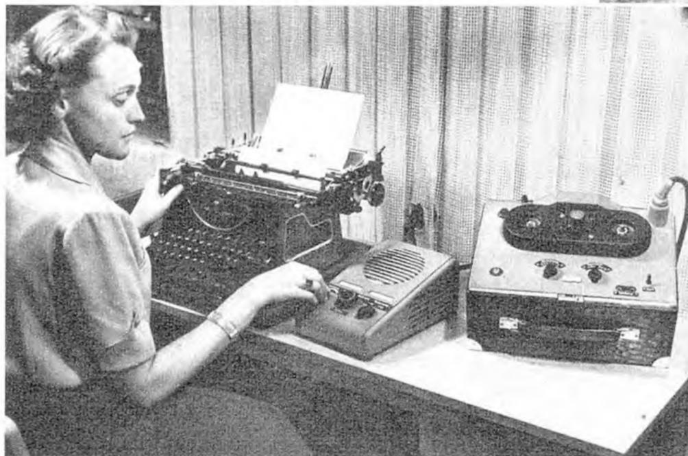
**Zugmeldespelcher „BG 4-10“** zeichnet automatisch fernmündliche Übermittlungen von Zugmeldungen auf. Das Gerät gestattet die selbsttätige Fixierung von Gesprächen bis zu einer Gesprächsdauer von 3 Stunden. Bei weiterer Aufnahme werden die letzten Aufzeichnungen automatisch gelöscht (Funkwerk Köpenick)
