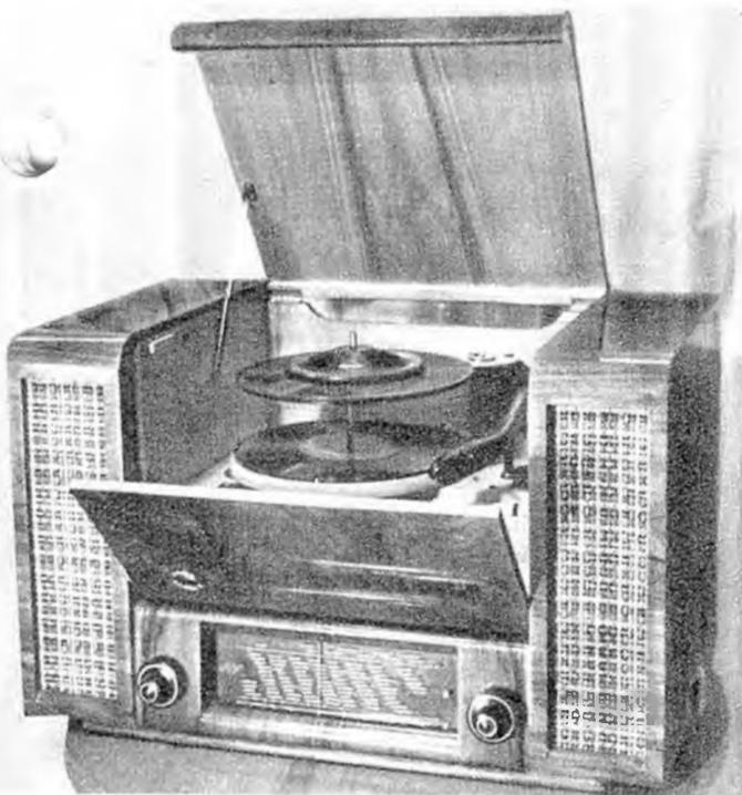
Rema-Fonosuper „Symphonie“ mit einem 10-Plattenwechsler der Firma Hummel & Seipius, Dresden, ein 10-(10-)Kreis-AM/FM-Super. In dem Gerät sind die neuen Gnom-Röhren von RFT verwendet. UKW-Teil mit HF-Vorröhre und eine KW-Bandspreizung
