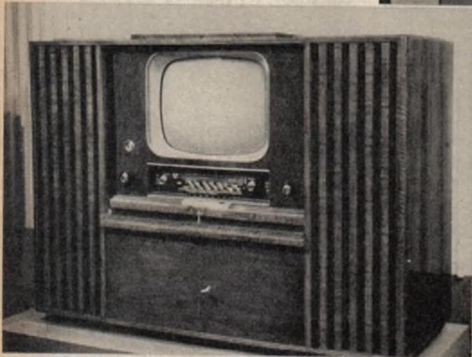
← Die Nora-Fernsehtruhe enthält außer dem Fernsehempfänger ein komplettes Rundfunkgerät
