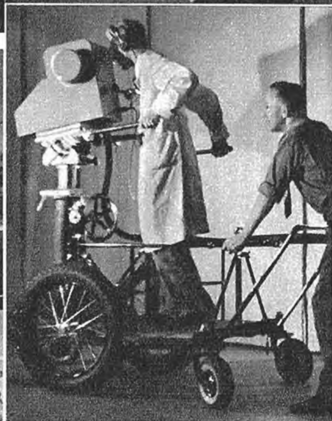
1937 Bühne des deutschen Fernsehsenders in Berlin mit Telefunken-Speicherbildempfängern. Oben: Bildfänger, beweglich auf einem Gabler-Wagen
