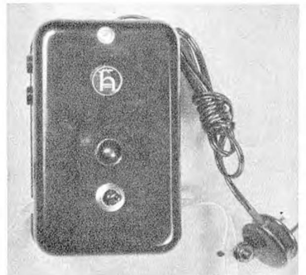
Abb. 3. Speisegerät für FS-Mast-Verstärker mit Trafo und 50-Hz-Weiche von Hirschmann
