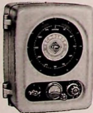
Außenansicht des anzeigenden „Echoskop“
