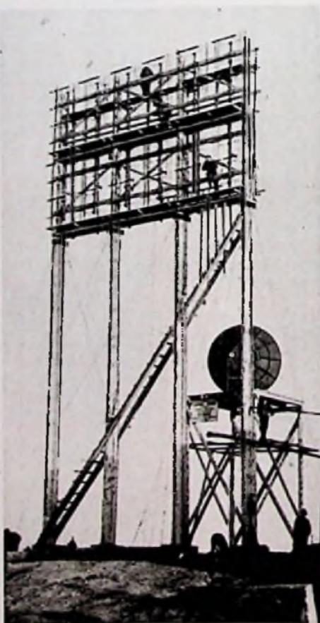
Abb. 2. Richtfunk-Antenne Hornisgrinde im Aufbau
