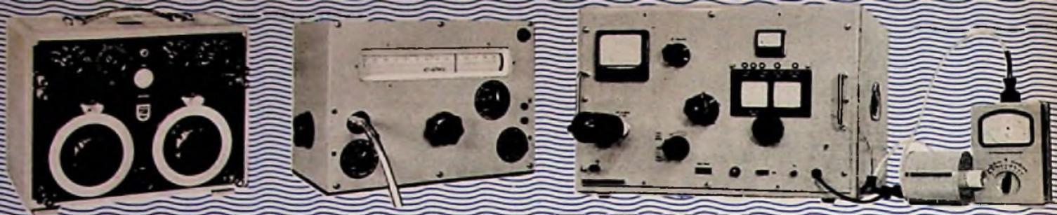
Von links nach rechts: NF-Schwebungsoszillator „GM 2308“ (Philips); AM-FM-Prüfsender (Sell & Stemmler); Leistungsmessender „LMS 68“ (Wandel & Goltermann)
