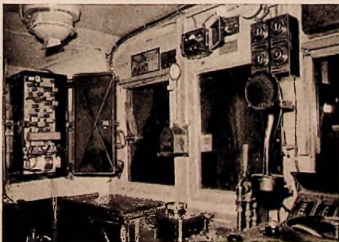
Abb. 10. Führerstand einer E-Lok mit Rangierfunkeinrichtung (Baujahr 1953)
