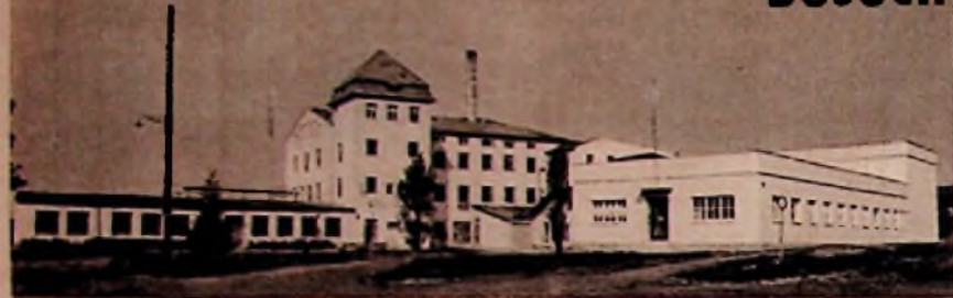
Teilansicht des Werkes III der RIG in Selb/Ofr.
