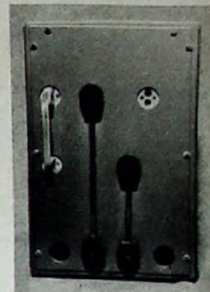
Rückansicht des Gestelles; im rechten Foto mit geschlossener Rückwand erkennt man rechts oben den Antennenanschluß und unten die Anschlüsse für den Handapparat und die Stromversorgung
