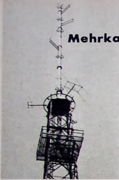
Bohrmast mit 4 Stadtfunkantennen für den Betrieb mehrerer Netze
