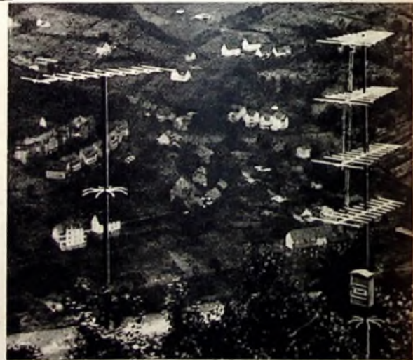
Blick ins Lenne-Tal. Abstrahlantenne mit Endverstärker (rechts im Foto) und Absorberantenne (links daneben)
