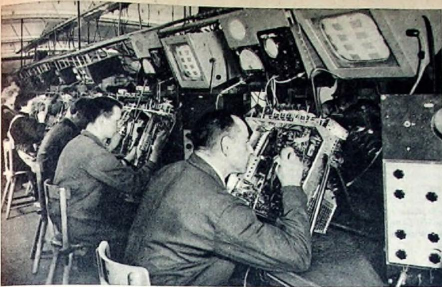
Abb. 3. Teilbild des Prüffeldes für FS-Empfänger. Abb. 4 (rechts). Die Transporte in den weiträumigen Hallen werden mit Elektroziigen und Gabelstaplern durchgeführt
