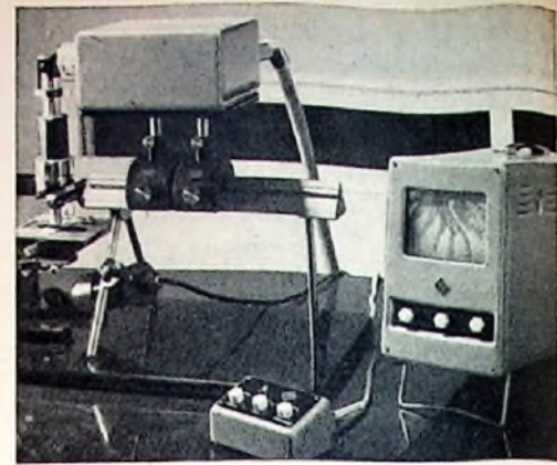
Industrielle Fernsehanlage von VEB Werk für Fernmeldewesen, hier zum Mikroskopieren von Organschnitten einer Stubenfliege eingesetzt
