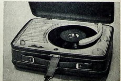
Phonokoffer „Lido“ von Telefunken für Batteriebetrieb mit eingebautem Verstärker
