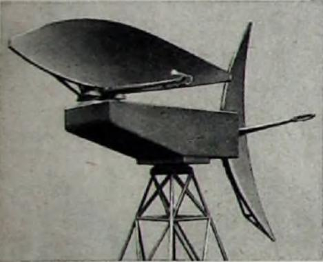
Bild 22. Antennensystem für eine Präzisions-Anflug-Radaranlage (Telefunken). Linke Antenne zur Ablesung des Azimutsektors, rechte zur Ablesung des Elevationssektors; jede Antenne gemeinsam für Sendung und Empfang im 3-cm-Band. Bündelung in der Ebene des Abtastsektors = etwa  $0,55^\circ$ ; Öffnungsbreite der Reflektoren = etwa 4,60 m
