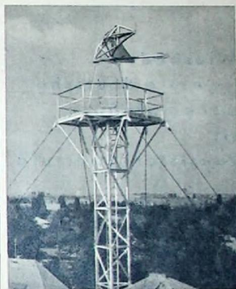
Der 23 m hohe Turm mit Drehantenne (4,6 m breit, Höhe einschl. Sockel = 3,6 m); Sender und Empfänger sind unterhalb der Antenne untergebracht
