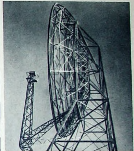
Der Antennenreflektor der Station Minorca (s. o. Titelbild); links ist der Antennenträger erkennbar
