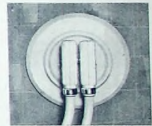
Bild 18. UP-Antennensteckdose mit Anschlußkabeln für Rundfunk und Fernsehen (Deutsche Elektronik)
