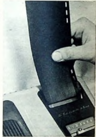
Einführen der Folie in das Diktiergerät „Stenomatic“ (Grundig)
