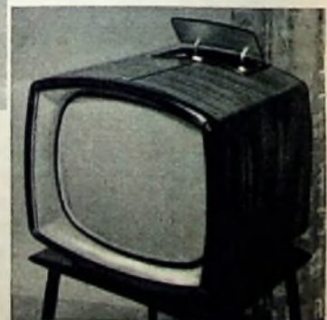
Fernsehempfänger „Lugana 21 T 210 U“ von Sandyna; 53-cm- (oder 43-cm-) Bildröhre, Vollbild-Front-Konstruktion, Empfindlichkeit etwa 30 \mu V, Spezialfilterschutzscheibe, Klarzeichner ◀ (Preis etwa 1100 sfr)
