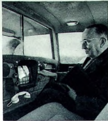
In einen neuen Simca-Wagen werden Fernsehempfänger und Telefon serienmäßig eingebaut
