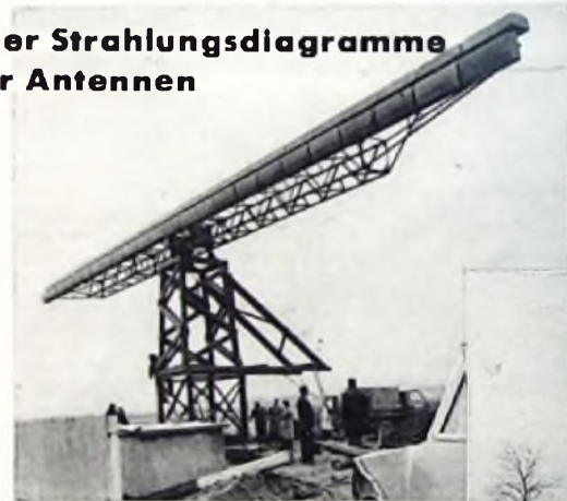
Parabolantenne zur Erzeugung einer gegen den Antennendrehstand fortschreitenden Welle
