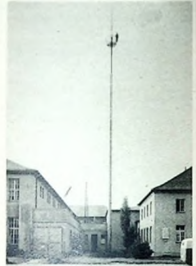
Bild 9. 40 m hoher Schleuderbetonmast als Antennenträger
