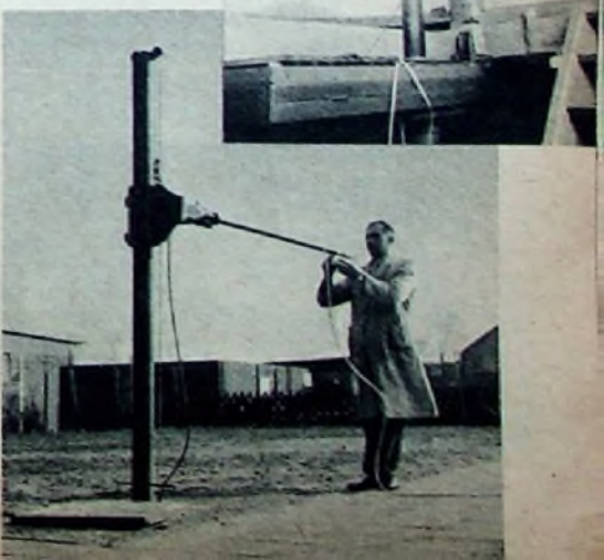
Meßantenne für die 10-m-Meßstrecke
