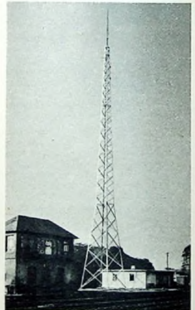
Bild 10. Verzinkter Gittermast als Antennenträger für eine ortsfeste Funkstelle
