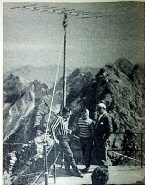
144-MHz-Antennenanlage (10-Element-Yagi von Fuba mit Ruß-Rotor) von DL 3 VD während des Europäischen UKW-Contests auf dem 2224 m hohen Nebelhorn in den Allgäuer Alpen. Links: Blick in die Arbeitsecke des Stationsraumes von DL 3 VD auf dem Nebelhorngipfel; im Hintergrund der UKW-Dreifach-Super, davor das Tonbandgerät „TK 1 Luxus“ (Grundig) mit Stationsmikrofon, rechts davon das Fernsteuergerät für den Ruß-Antennenrotor. (Aufnahmen: Dielenbach)
