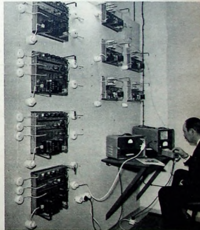
Bild 3. Der Hauptverstärkerraum der Gemeinschafts-Antennenanlage enthält außer den Hauptverstärkern und den Verteilern auch einen Meßplatz mit LMKU-Antennenprüfgerät (links) und Fernseh-Antennenprüfgerät mit UHF-Vorsatz (rechts)
