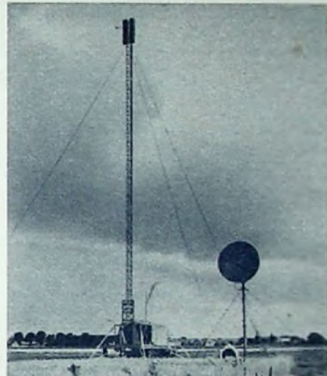
Gegenstation mit mobilem Funkmast des Antennenmeßstandes
