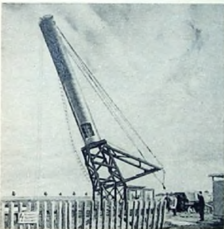
Eine Band-IV-Sendeantenne von Rohde & Schwarz mit zylindrischem Vereisungsschutz auf dem Meßstand
