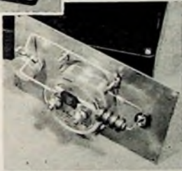
Bild 3. Blick in die Verdrahtung des Feldstärkeprüfers
