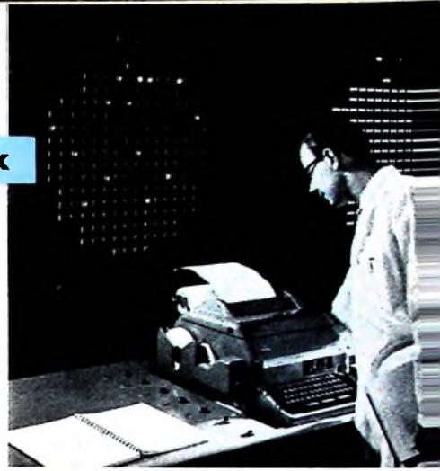
Meßwandrucker mit parallelschaltem Streifenlocher in einer Anlage für die Betriebskontrolle
