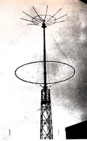
Rundstrahlantenne (Discant) für 5,5...22 MHz (bis 50 kW); der 50 m hohe Antennenturm dient gleichzeitig als Stützpunkt für eine Doppelhombusantenne
