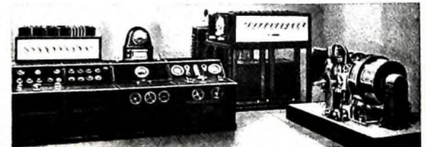
Lorenz-Paulsen-Sender mit 50 kW Ausgangsleistung. Unten: Maschinensender der Funkstation Königswusterhausen mit 50 kW Ausgangsleistung
