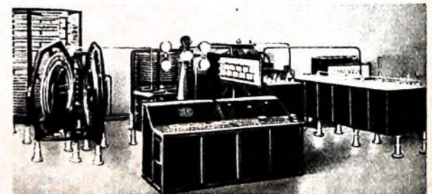
Lorenz-Paulsen-Sender mit 50 kW Ausgangsleistung. Unten: Maschinensender der Funkstation Königswusterhausen mit 50 kW Ausgangsleistung
