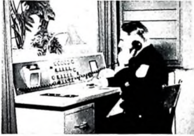
Kommandotisch und Steuerschrank der Funkalarm-Anlage bei der Freiwilligen Feuerwehr Füssen
