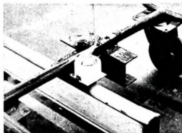
Die automatische Stromzuführung für die Montagewagen
