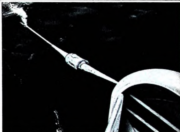
ICECAN Verstärker während der Legung
