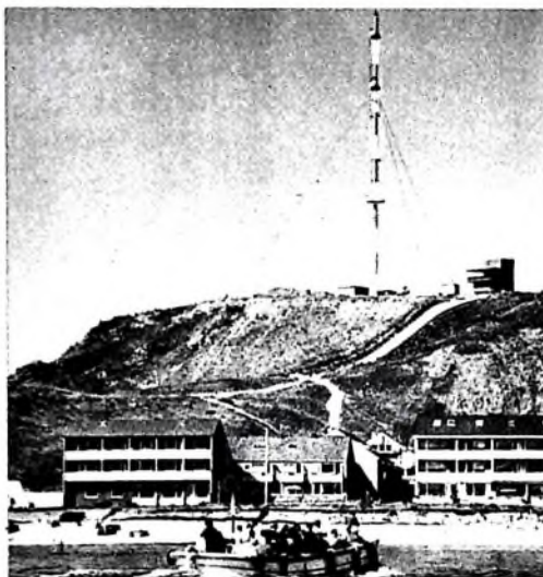
Oben links: Gesamtansicht der Richtfunkstation auf Helgoland. Oben rechts: Der obere Teil des Richtfunkturmes mit den verschiedenen Antennen; bis zur Plattform ist der Antennenmast von innen bestiegbar.
