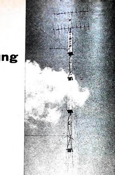
Antennengittermast mit dem 2 x 10-Elemente-Dipol für 144 MHz auf dem Gelände der DARC-Sonderschau
