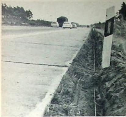
Bild 6. Verlegung der Induktionsschleife bei Berkhof
