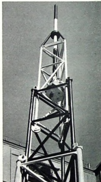
Bild 7. Blick auf die Mechanik des ausfahrbaren Stahlgittermastes (Stotz und Goessl)
