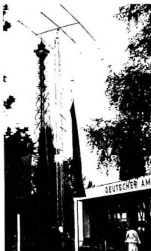
3-Element-Drehrichtstrahler auf einem etwa 18 m hohen Gittermast vor dem DARC-Pavillon
